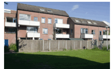
Tussenwoning met EPC = 0,57
